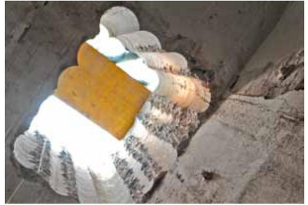
Um sich durch die 1,6 m dicke Stahlbetondecke zu arbeiten, benötigten die Handwerker 40 Bohrungen und rund sechs Wochen Zeit
